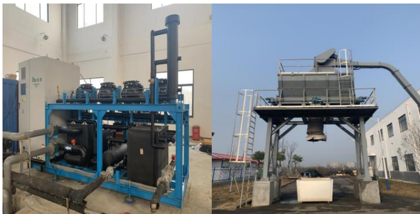
图 6 苏净巢湖东城污水处理厂污泥干化二氧化碳冷热联供机组（冷水-热水型）
