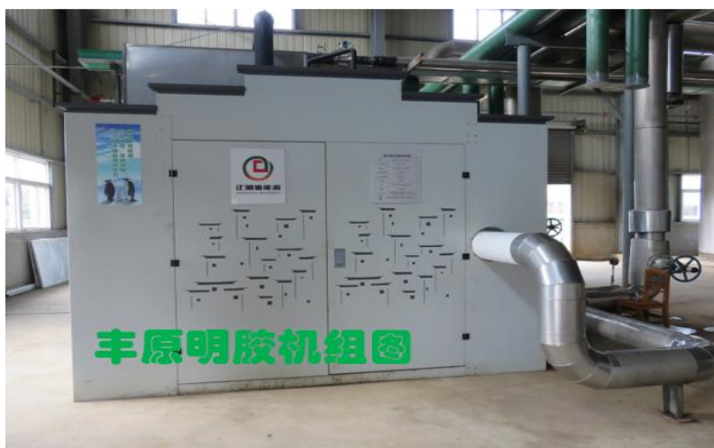
图 2 正刚安徽丰原明胶二氧化碳冷热联供机组（冷水-热水型）
