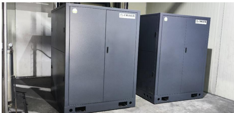
图 3 正刚福建明胶二氧化碳冷热联供机组（冷液-热水型）
