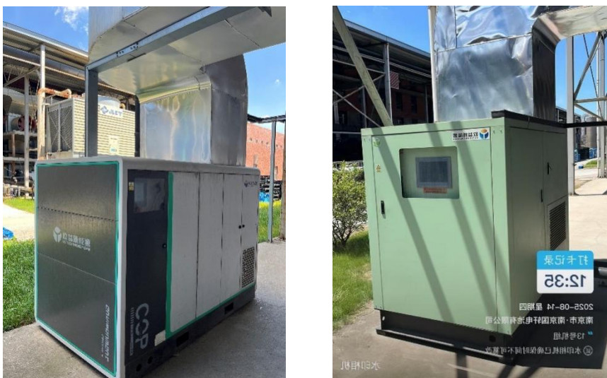
图 4 正刚国轩高科转轮除湿二氧化碳冷热联供机组（冷水-热风型）
