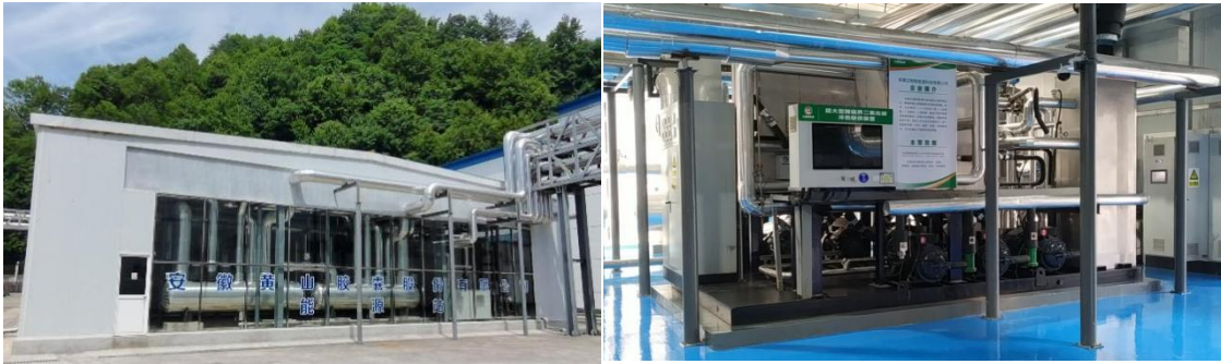
图 1 正刚黄山胶囊 GMP 恒温恒湿车间二氧化碳冷热联供机组（冷水-热水型）
